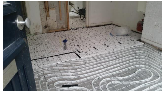
Figuur – vloerverwarming op schuimbeton
